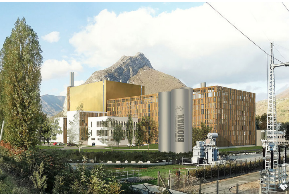
Futur site de production Biomax, situé sur le site du CEA, alimenté à 100 % en bois.
