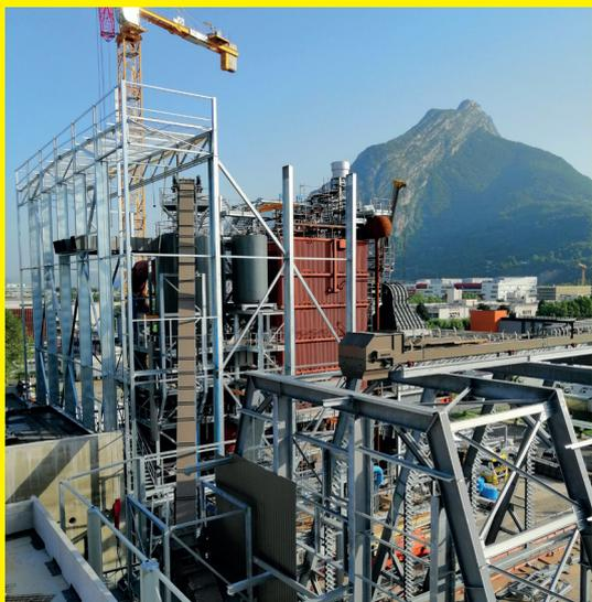
Le chantier, qui a débuté en juin 2018, s'est d'ores et déjà traduit par des travaux de gros œuvre du bâtiment de la chaudière et de la zone de séchage de la biomasse puis du bâtiment de cogénération et du générateur d'appoint. Le montage de la chaudière a quant à lui démarré en décembre dernier.
